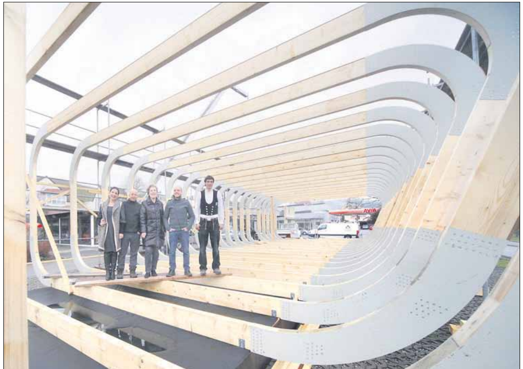
Benjamin Fleck (rechts) legt als Zimmermann selbst Hand an. Der Rest (von links) wartet mit Spannung auf das Endergebnis: Petra Dannenmann, Uli Brunner, Heike Stahl und Architekt Gunter Scholz. Bild: Habermann
