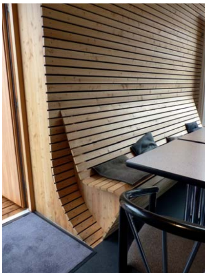
Konsequent: Teile der Möblierung sind fest in die Konstruktion der Wandverkleidung integriert.
